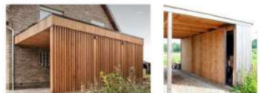
Carport intégrant un rangement.
